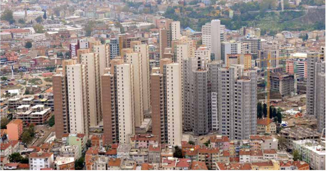
"Doğru bir kentsel yerleşim yapılmayıp, kentsel dönüşümle yapılan kentsel yerleşim"/ "Urban settlement with no urban settlement"
